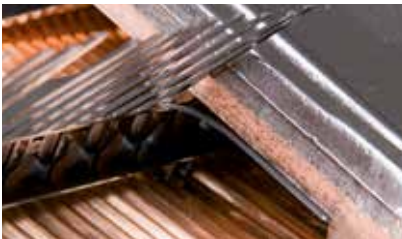
Der Traufenlüftungskamm bietet Schutz vor Vogeleintrieb.
